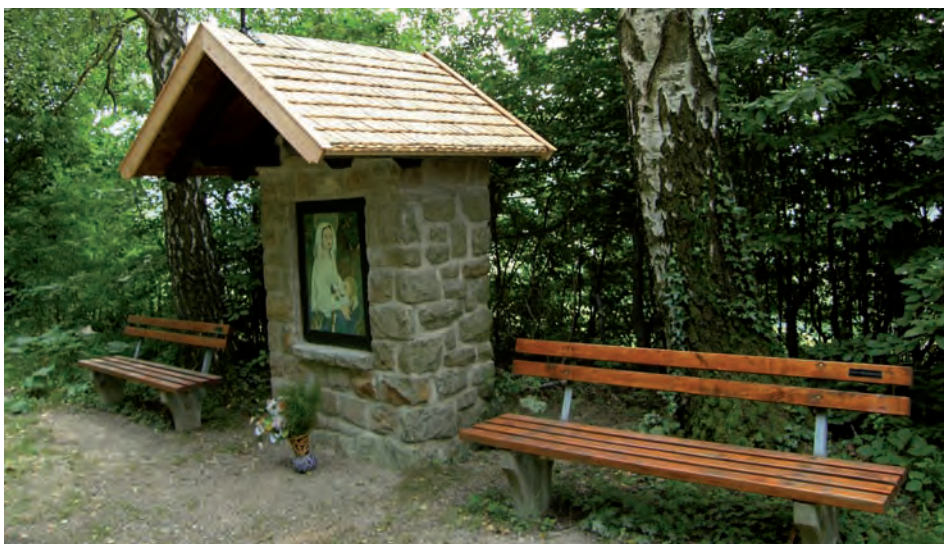
Das Marterl Maria mit den Waldtieren wurde mit neuen Wienerwald Holzschindeln gedeckt.
