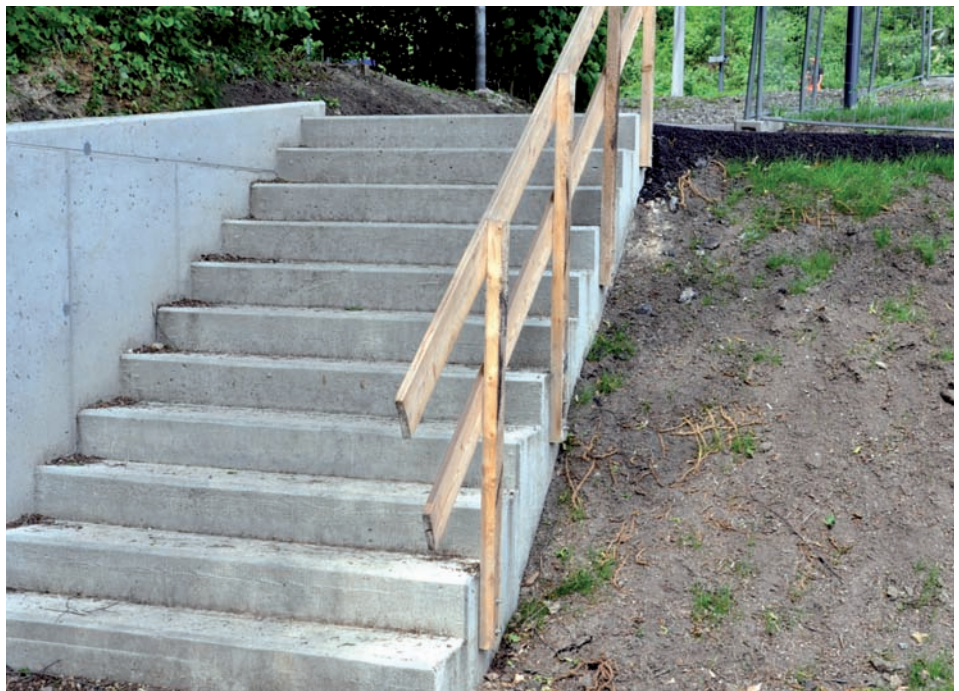
So steil präsentieren sich derzeit noch die Stiegen beim Bahnhof Pressbaum.
