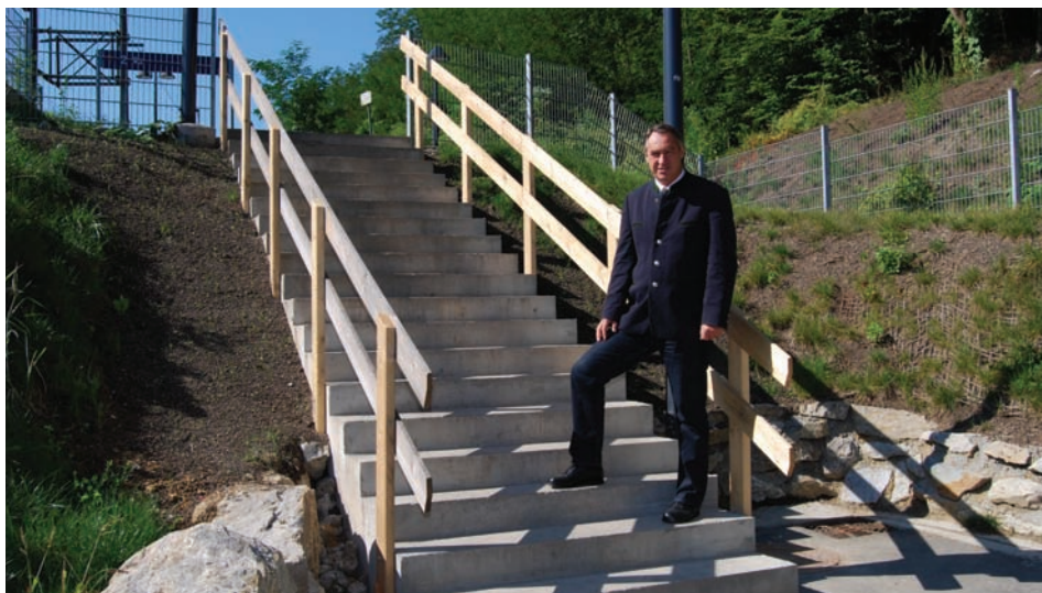
Bürgermeister Josef Schmidl-Haberleitner überzeugte sich vom Umbau der Stiegen am Pressbaumer Bahnhof.
