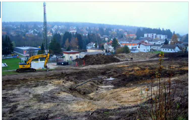
Die Erdarbeiten für den neuen Trainingsplatz sind schon weit fortgeschritten.
