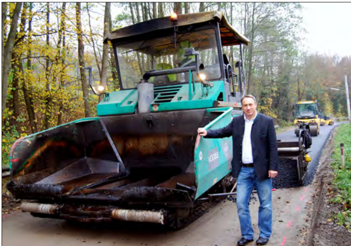
Bürgermeister Schmidl-Haberleitner besichtigte den Bau der neuen Straße in der Kaiserbrunn
